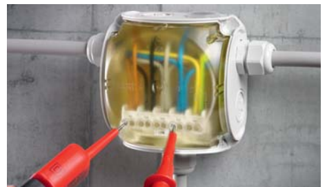
■ Der Deckel kann entfernt und eine Messung durchgeführt werden.
