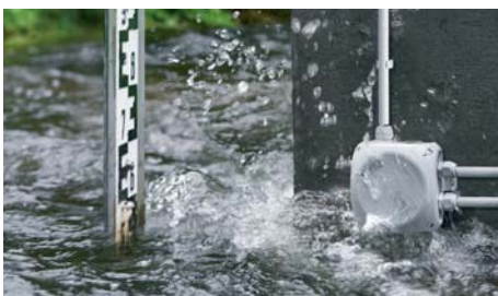
■ Durch das Vergießen der Kabelabzweigkästen werden der Eintritt von Flüssigkeiten und Kondenswasserbildung vollkommen ausgeschlossen.
